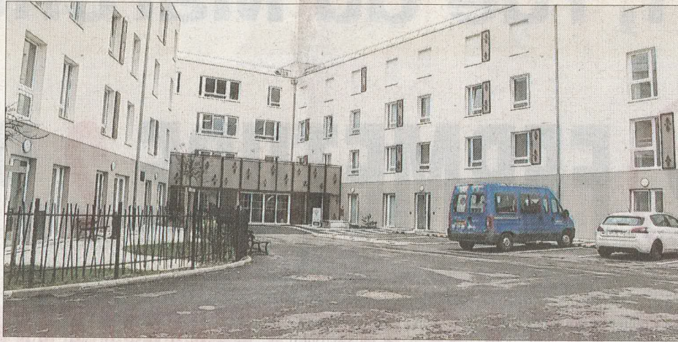
Une maison de retraite flambant neuve, dont le troisième étage reste désespérément clos.
